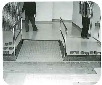
玄関にスロープを設置
